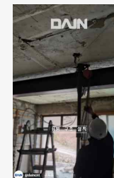
상부 슬래브 H빔 양중완료
